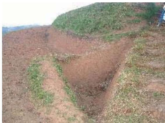
Vasca di assorbimento del ruscellamento
